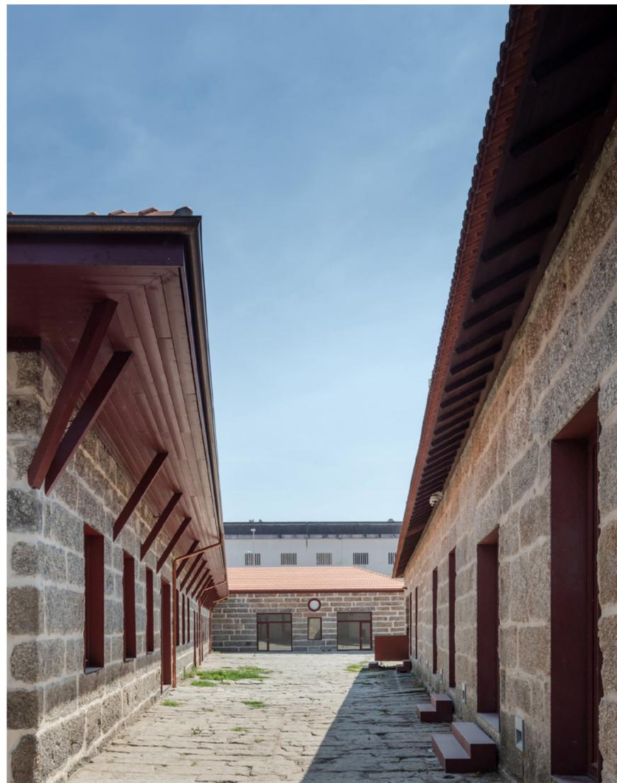
O edifício desenvolve-se numa planta em "L", de espaços amplos, subdivididos por elementos, construtivamente pobres e sem valor arquitectónico, que foram demolidos, sendo que, a estrutura tradicional da cobertura, em asnas e vigas de madeira, foi integralmente reabilitada e reconstruída.
