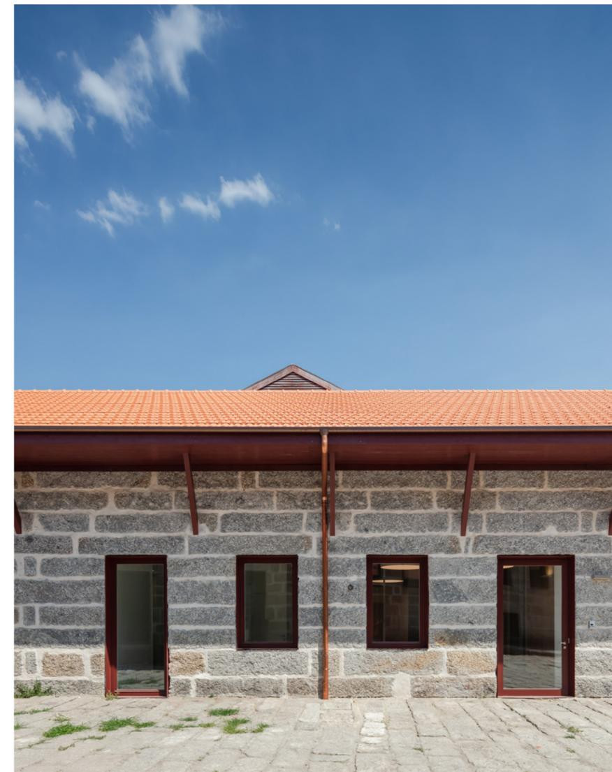
Houve a total preocupação de manter o traço e os materiais existentes, caixilhões em madeira com a cor original, telhado com telha Marselha, rufos e mansardas em cobre, clarabóias executadas no mesmo local das existentes, fachada ficou integralmente em Pedra Granítica tipo perpianho com reabilitação das juntas e da sua estabilidade integral ao nível das fundações e coberturas.
